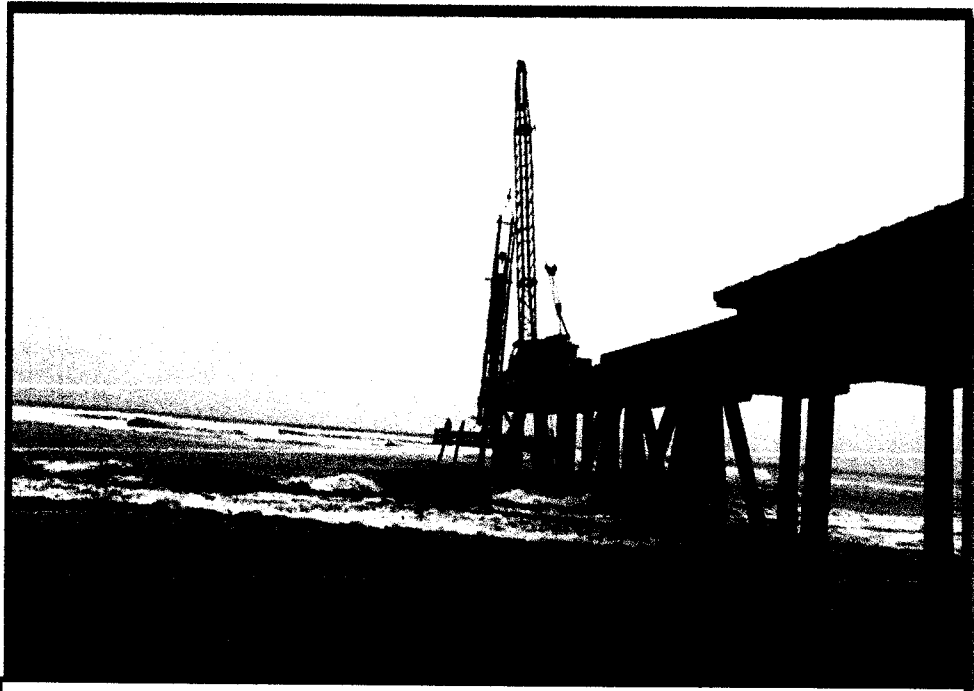
Imagen N°03.- Realizando trabajos de hincado de pilotes.
