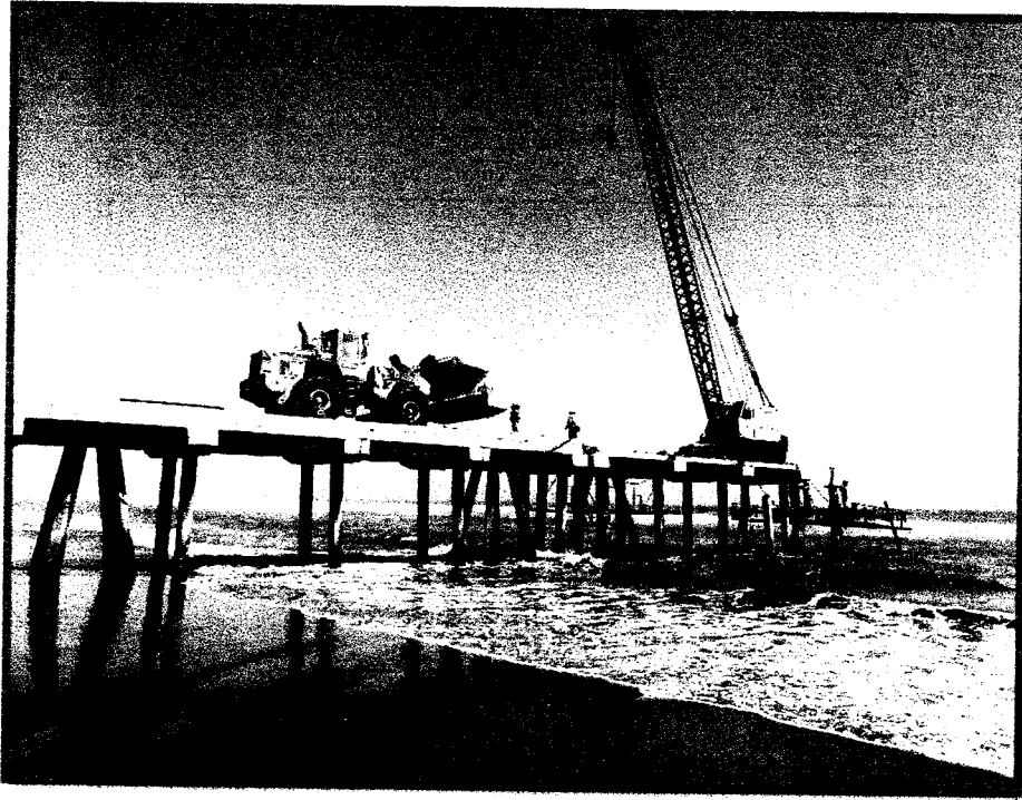
07.04.07.07 COLOCACION DE VIGAS TRANSVERSALES.
