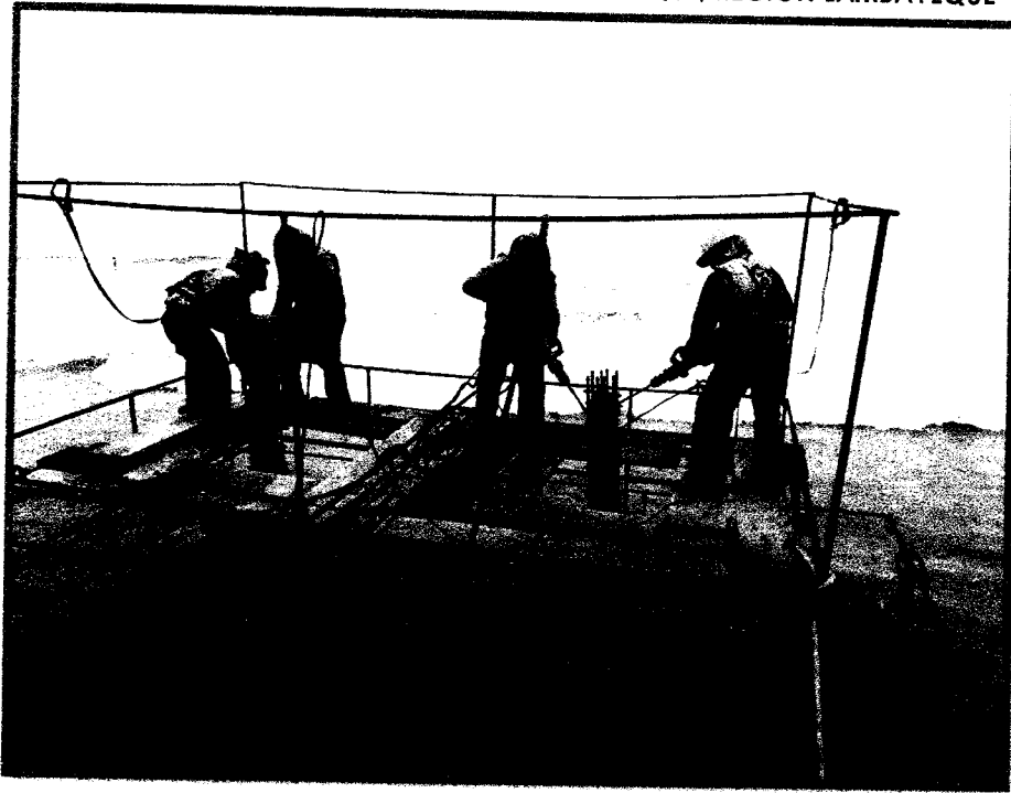
DESCABEZADO DE PILOTES
