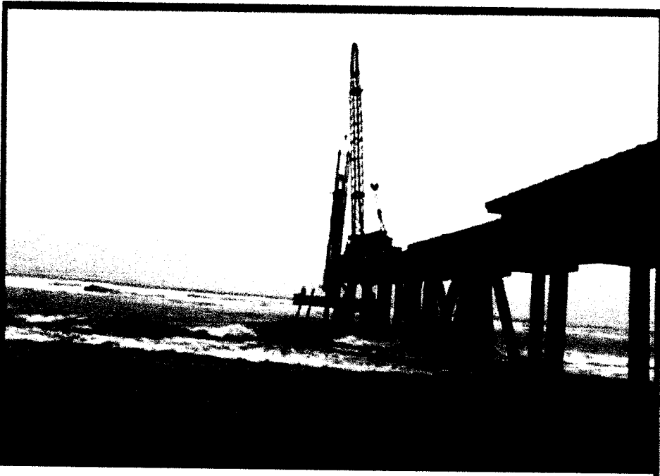
Imagen N°03.- Realizando trabajos de hincado de pilotes.
