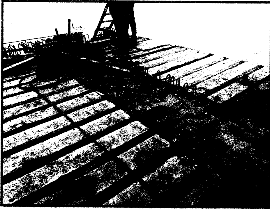
COCRETO, ENCOFRADO Y A CERO EN JUNTAS LONGITUDINALES
