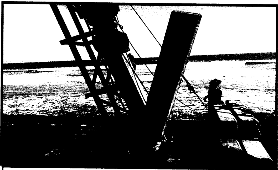
Imagen N°02.- Hincado de pilotes.
