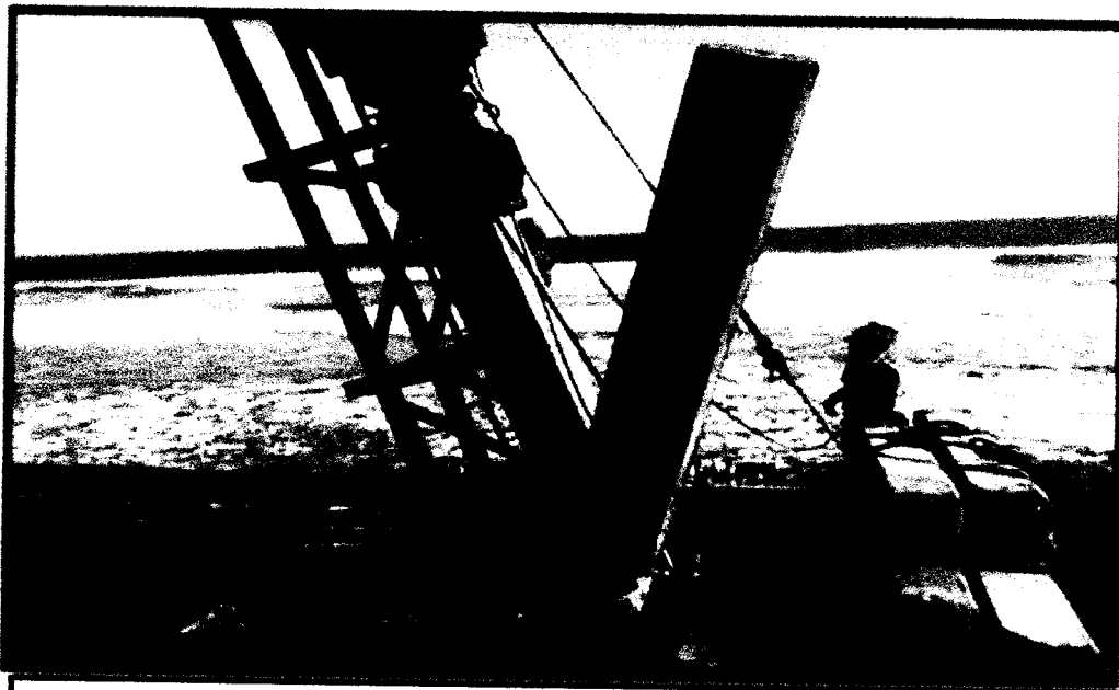
Imagen N°02.- Hincado de pilotes.
